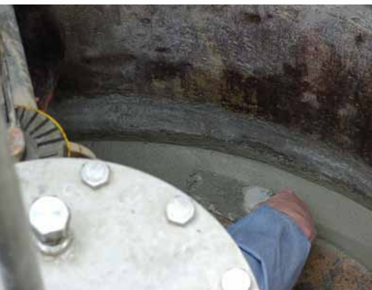
Aplikacja materiału na styku ściany z dnem studzienki
