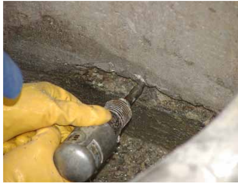
Przygotowanie podłoża
