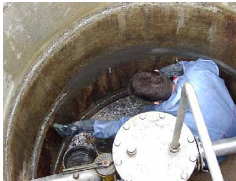
Uszczelnienie przecieków
