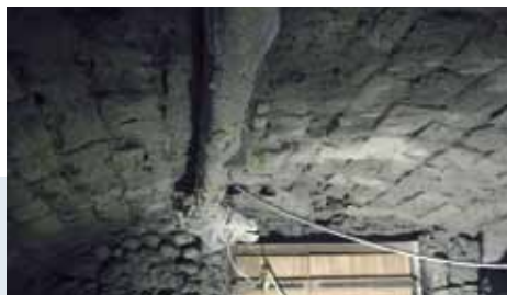
4 Pierwsza warstwa; VANDEX UNI MORTAR 1
