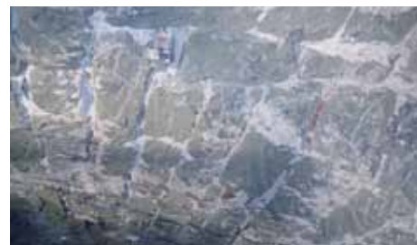
3 Oczyszczona powierzchnia z uszkodzonego tynku
